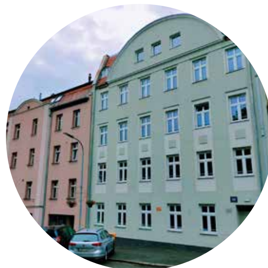
ul. Piłsudskiego budynek po termomodernizacji
