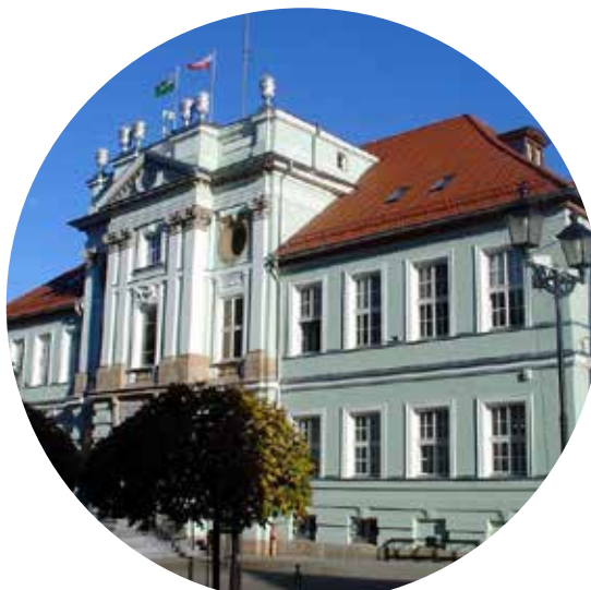
Urząd Miasta wymiana ogrzewania i termomodernizacja
