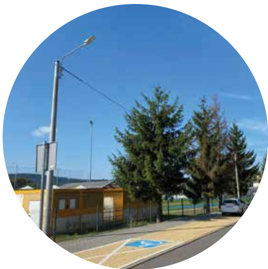
Oświetlenie ledowe wymiana oświetlenia ulic
