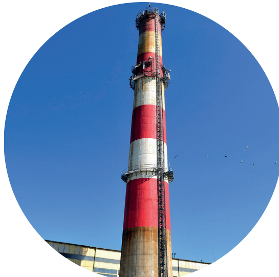
Miejski Zakład Energetyki Ciepłej plany inwestycyjne
